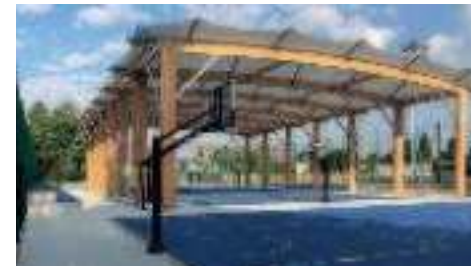
Abb. 81: Beispiel für eine realisierte Spielfeldüberdachung im Jahn-Sportpark Pankow
