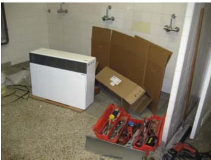
Kooperativer Bezirk - noch vor der Sanierung durch den Verein werden vom aktuellen Eigentümer Reparaturarbeiten erledigt.
